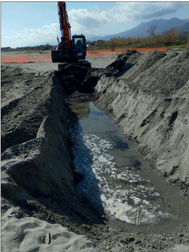
Fig. 28 Dans les tranchées, l'eau de mer remonte rapidement et vient faire effondrer les bermes © A. Sabastia, Inrap
